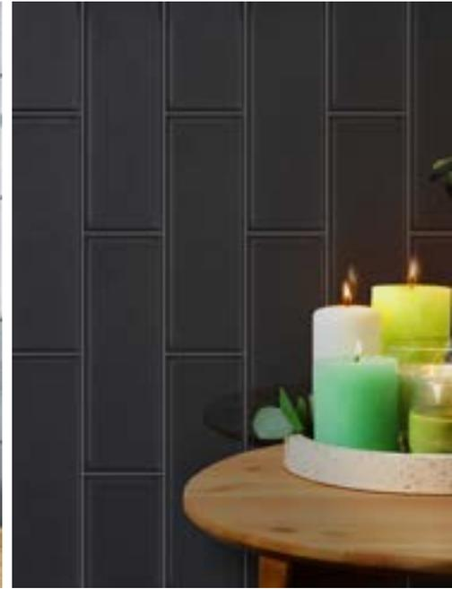
Aplicación tipo ladrillo vertical con junta de contraste de 3mm.
