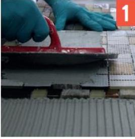
1 Sobre una superficie diferente al piso (para evitar rayado) aplica pegante en la parte posterior del mosaico. (doble encolado).
