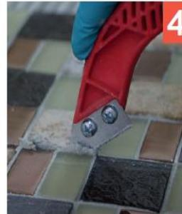
4 Retira el exceso de pegante con un rascador de juntas. Se recomienda dejar secar 24 horas el pegante antes de emboquillar.
